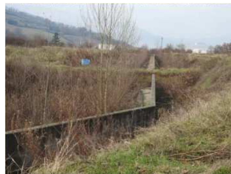
Figure 35-36 – Opere di contenimento a monte dell'intervento realizzate dalla società Massolina s.r.l.
