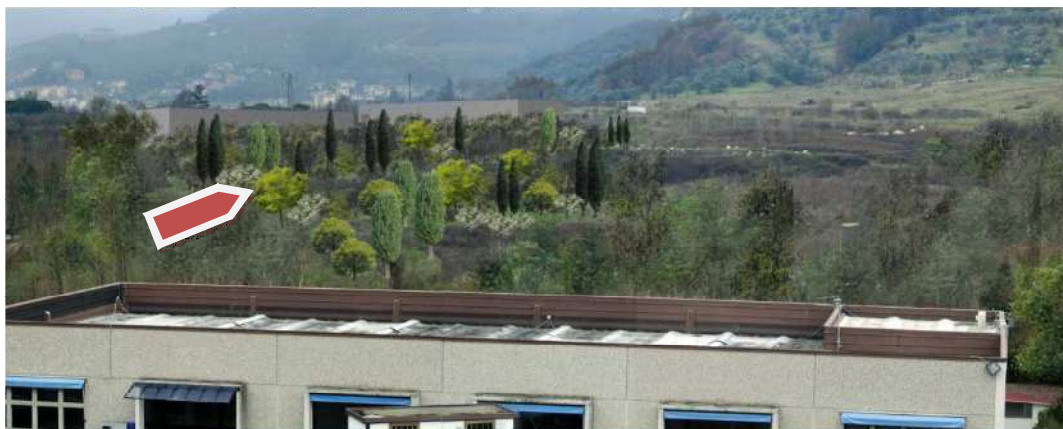
Figura 40 - Foto inserimento dei capannoni con il bosco di mitigazione indicato dalla freccia
