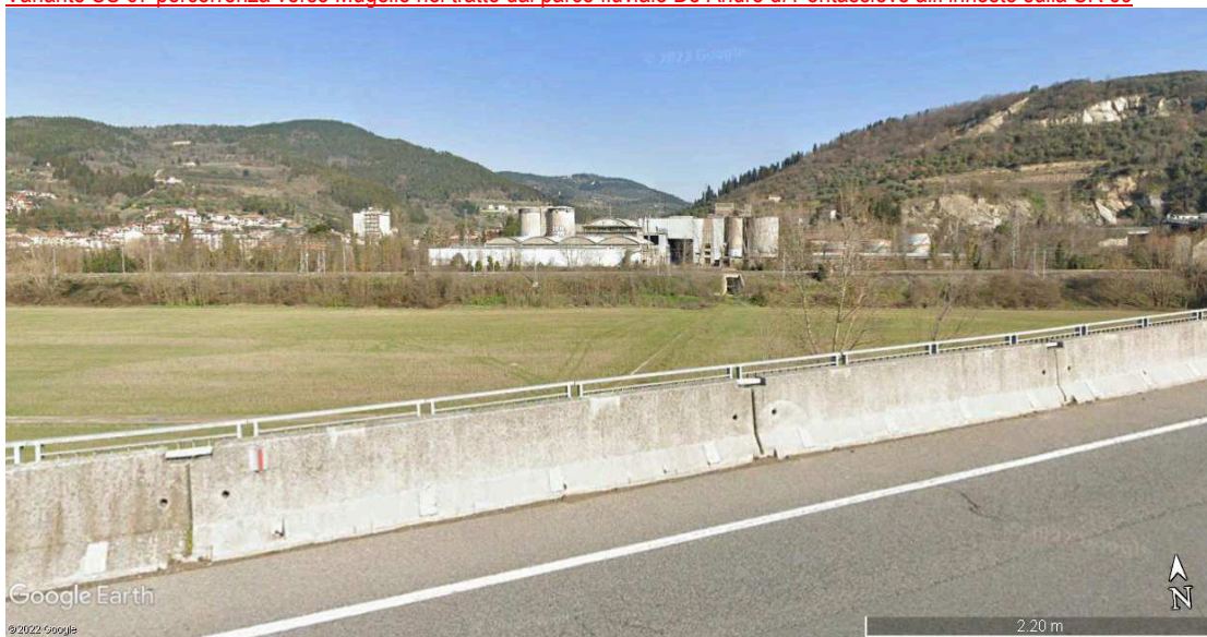
Variante SS 67 percorrenza verso Mugello nel tratto dal parco fluviale De Andrè di Pontassieve all'innesto sulla SR 69
