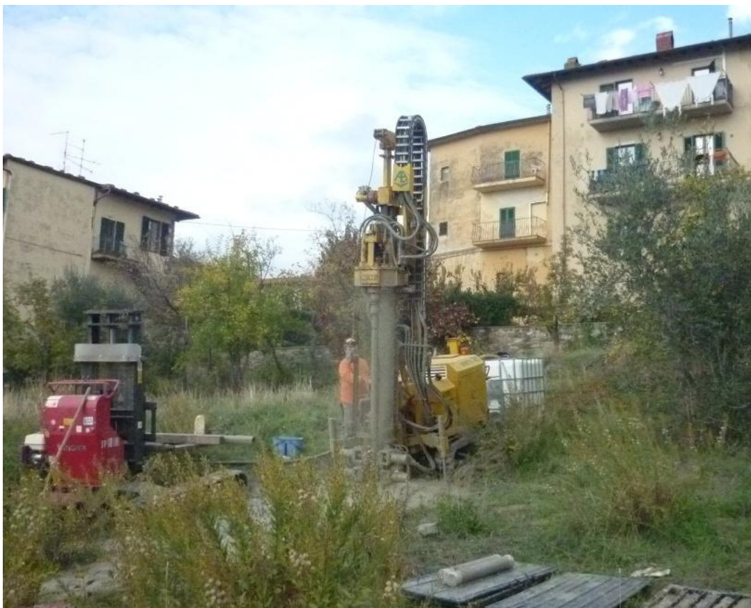
Perforazione a distruzione 16,50 – 18,00
