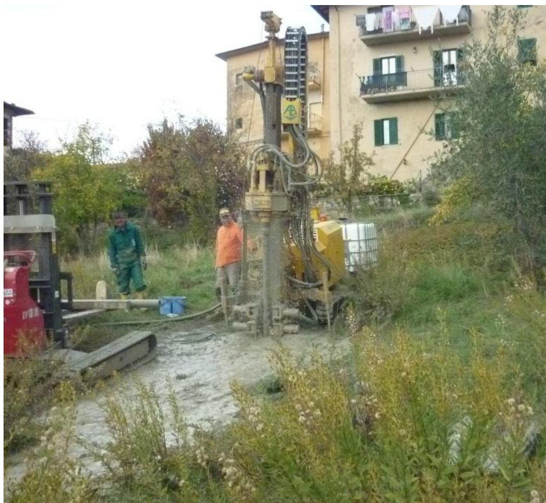
Perforazione a distruzione 19,50 – 20,50
